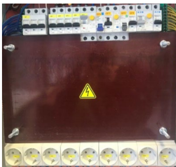
Рисунок 3.1 – Стенд для электрофизических измерений (ЩС-4)
